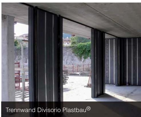
Intern wird die Füllung trocken mit geeigneten Schichten zur akustischen Korrektur und Wärmedämmung für die warme Jahreszeit ergänzt. Für außen sind trockene Finish oder Finish Typ Thermohaut vorgesehen.
