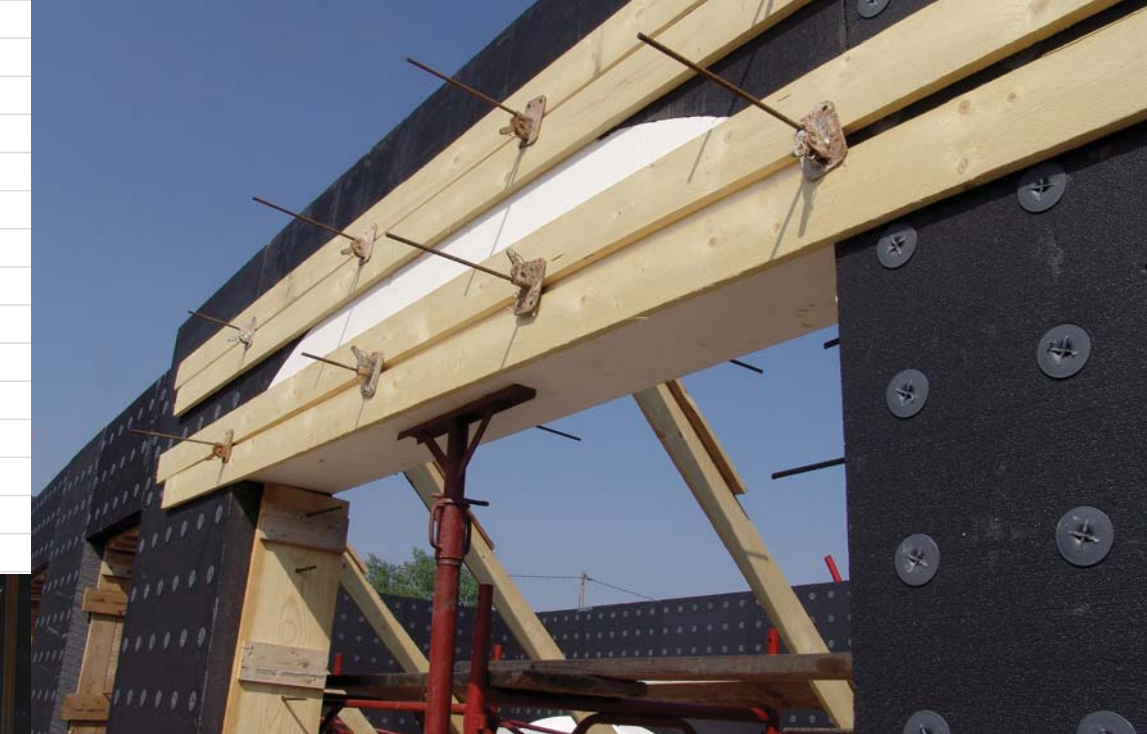
Montage von Schalungen an gewölbten Architraven
