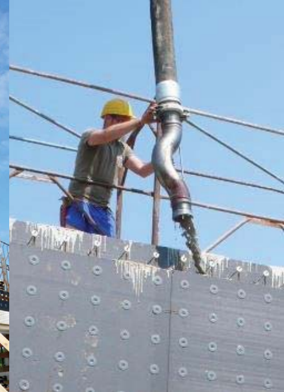
Betonguss mit Pumpe
