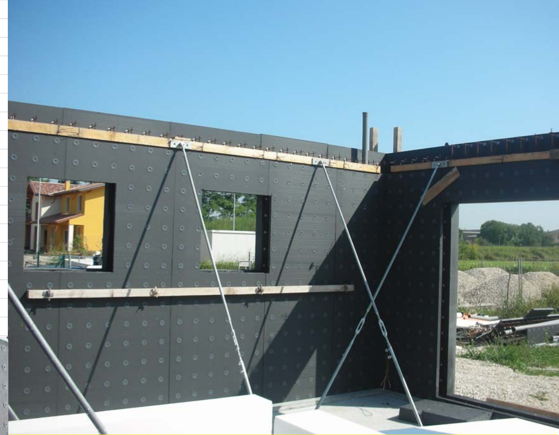
Metallelemente mit Zug- und Druckkräften
