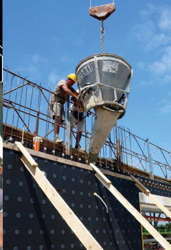
Betonguss mit Kübel
