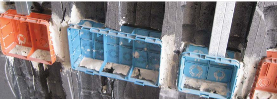
Installationen, Kanäle an der Innenseite der Wand Plastbau® 3
