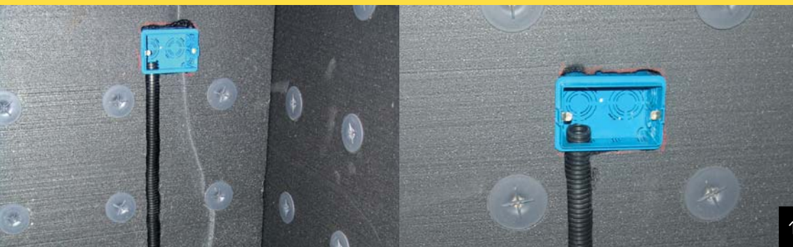
Installationen, Kanäle an der Innenseite der Wand Plastbau® 3
