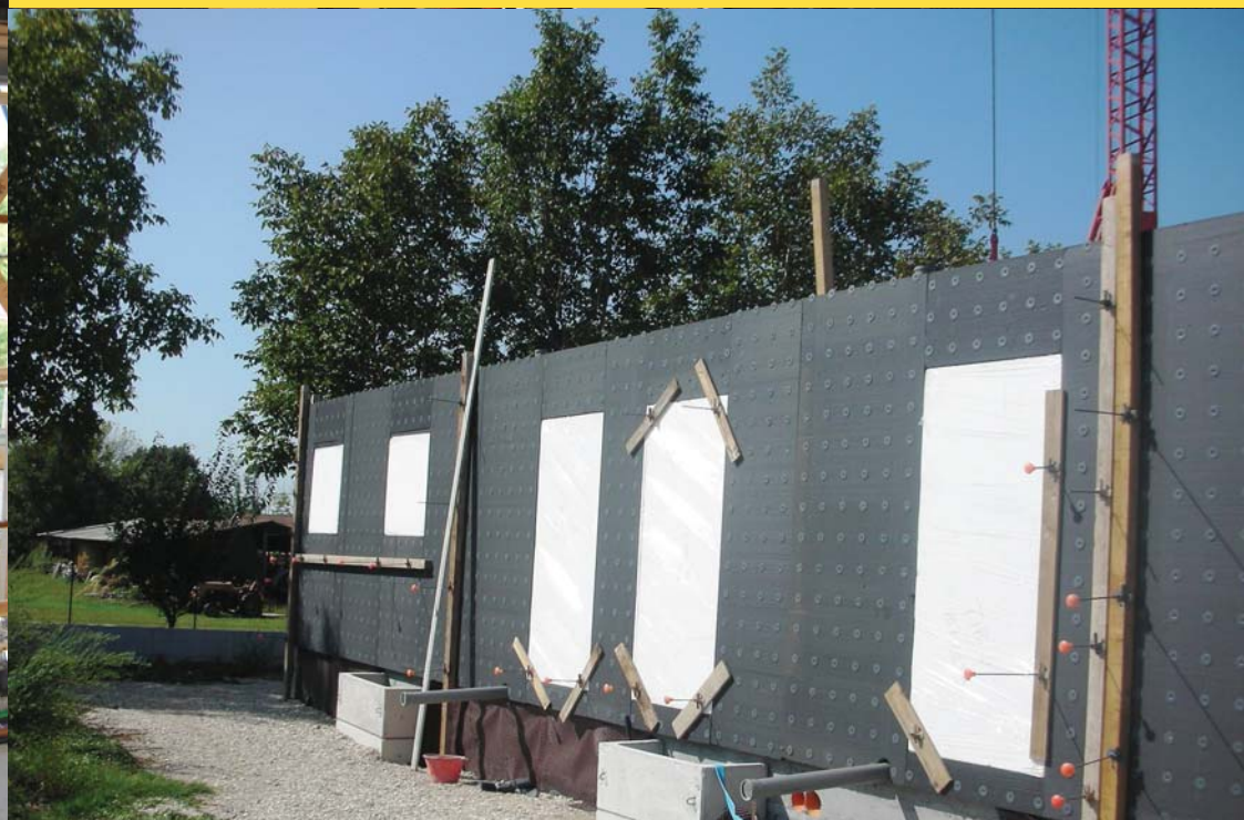
Montage von Schalungen mit maßgefertigten EPS-Blöcken
