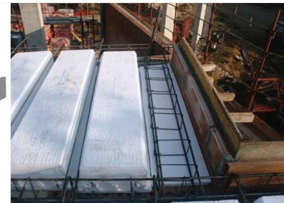
**POLIARMO** ermöglicht den Erhalt von geraden Platten mit perfekt parallelen Kanten sowie die beinahe vollständige Beseitigung von Ausschuss, da die Platte dicht nebeneinander positioniert werden können, bis die gewünschte Breite erreicht ist. In Kombination mit der Schalung **Plastbau® Metall** beseitigt es unter den Balken die Wärmebrücken der gesamten Bodenplatte.
