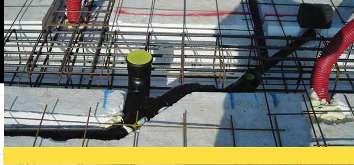
Die freiliegenden Stahlprofile **Plastbau® Metall** auf der Intradosebene können neben dem Deckenraster auch Installationen, Rohrhalterungen oder Rohrbündel aufnehmen.
