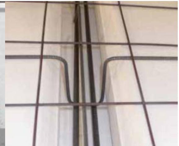
Stahlschellen Ø6mm werden vor dem Gießen im Abstand von 150cm in die Zwischenräume der Bodenbalken eingesetzt; die Schellen stützen die unteren Bewehrungsstäbe ab, lösen sie von der Plattenunterseite und gewährleisten die minimale Betondeckung der Bewehrung.
