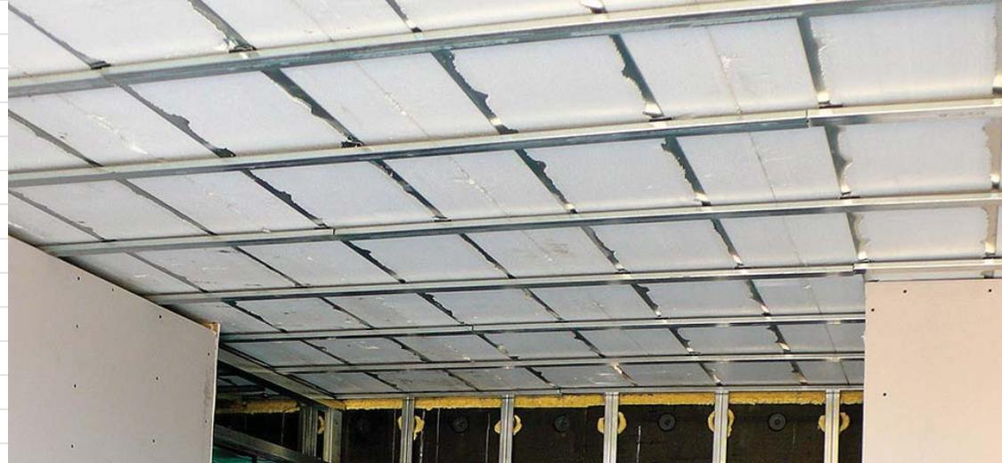
Sekundärrahmen für Plattenverschraubung
